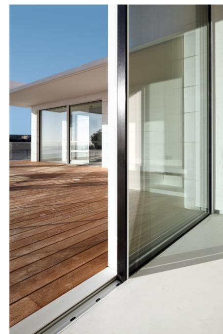
Flache Schwelle sorgt für einen komfortablen Übergang von innen nach außen
